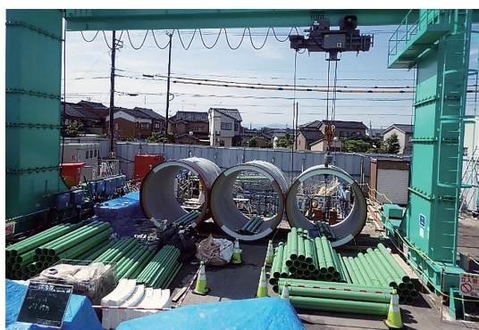
写真-2 発進ヤード
