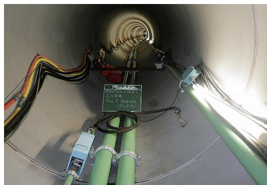
写真-4 管内配管設置状況
