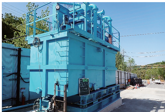
写真－11 一次処理機に防振ダンパを設置した例
