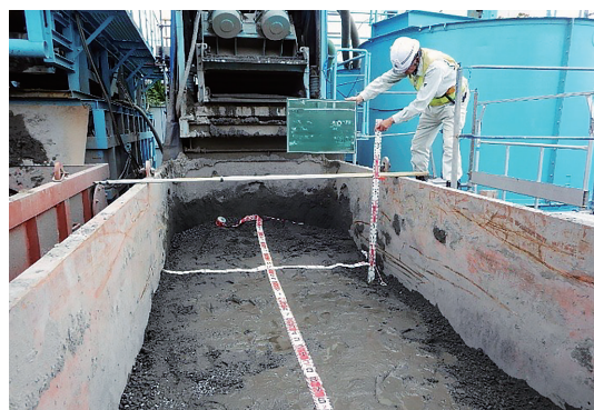
写真－10 残土量計測状況
