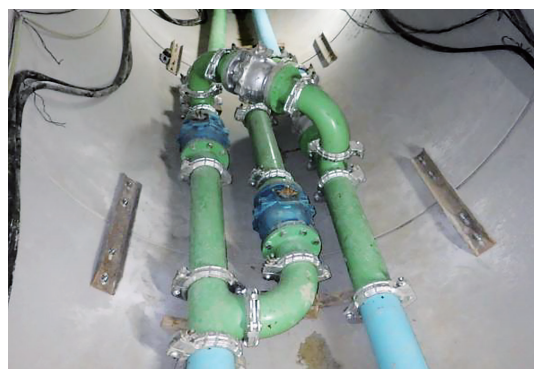
写真－3 管内緊結と配管閉塞対策の配管バイパス弁設置状況
