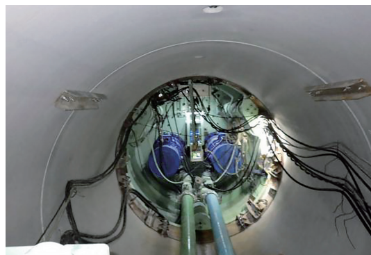
写真－2 機内緊結状況
