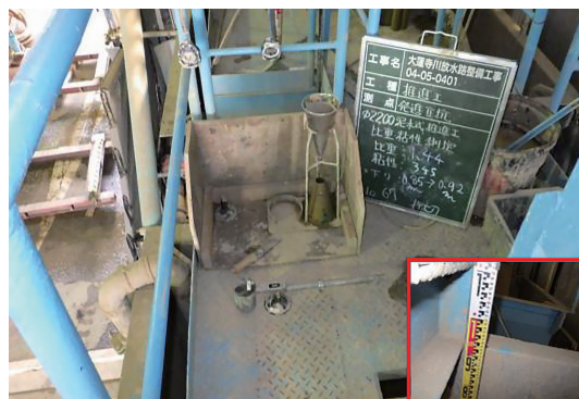
写真-4 泥水濃度測定状況
