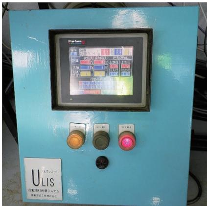
写真-1 中央集中制御盤
