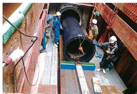
写真-1 NS形管の挿入状況 1)
