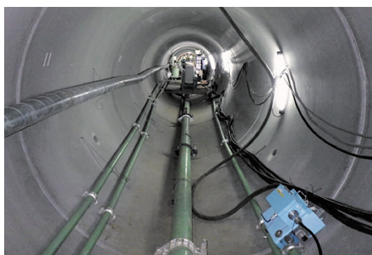
写真-2 自動滑材注入システム（管内）設置状況
