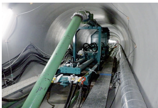
写真ー5 第二土砂圧送ポンプ設置状況
