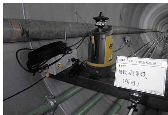
写真-3 PipeShot測量機（管内）設置状況
