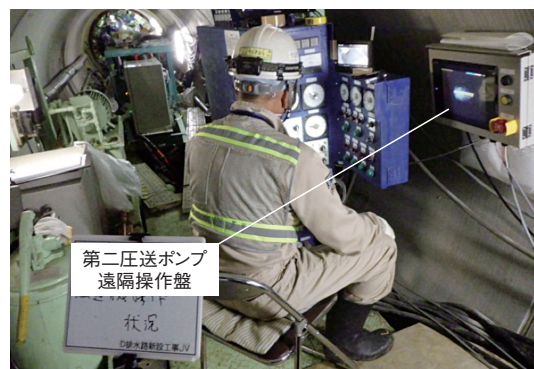
写真ー6 第二土砂圧送ポンプ遠隔操作状況
