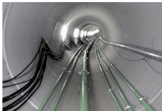
写真-1 複合曲線区間推進管内
