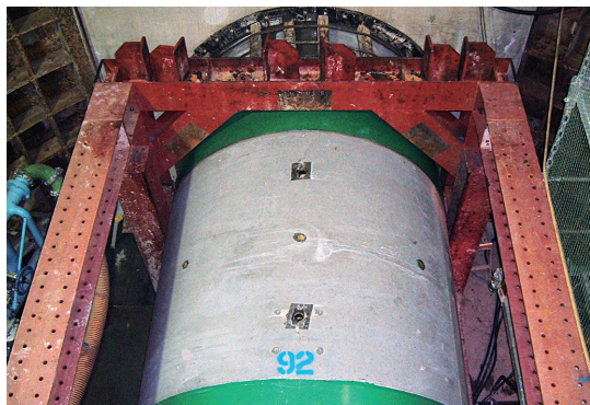
写真-7 バックキング対策状況 (発進坑口手前に浮上防止バンドも装置)
