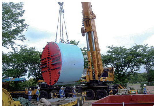
写真-6 掘進機投入状況
