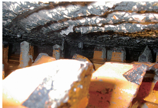
写真-5 NOMST切削状況
