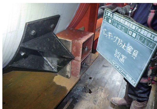
写真-7 バッキング防止金具取付け状況
