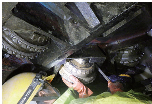
写真－3 チャンバ内でのビット交換状況
