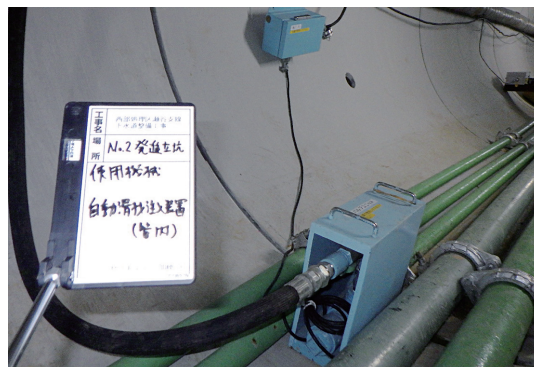
写真-9 自動滑材注入装置
