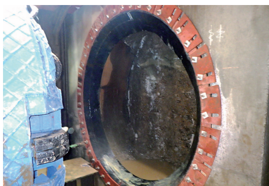
写真-6 発進坑口L型パッキン取付け状況
