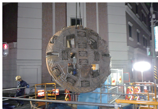
写真-15 掘進機分割回収
