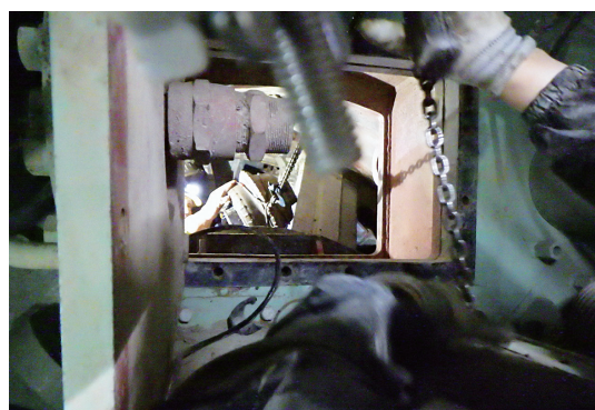
写真－4 交換用ローラビットのチャンバ内への搬入状況
