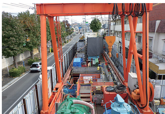
写真-1 狭い発進ヤード
