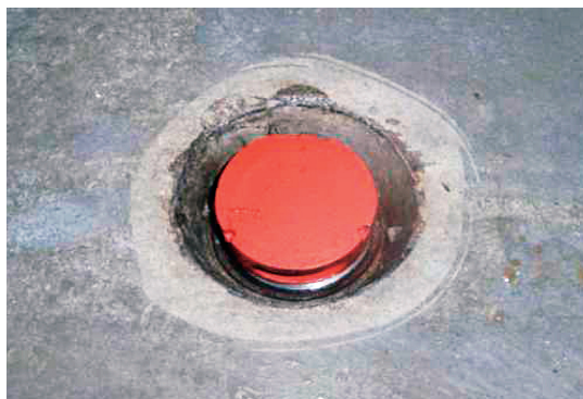
写真-5 グラウトホールキャップ取付け状況
