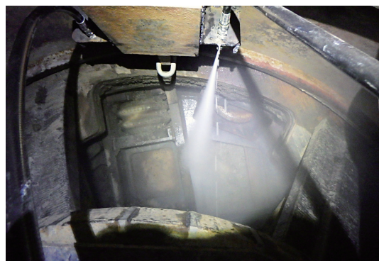
写真－11 チャンバ内超高压喷射設備
