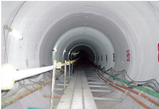
写真-11 管内状況（呼び径3000）
