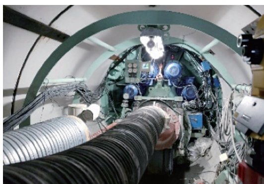
写真-7 掘進機カッターモータ防爆仕様
