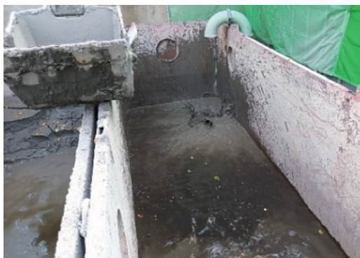
写真-2 排土状況（地上土砂タンク）
