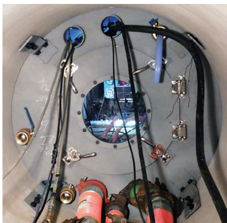
写真-7 掘進機水没防止用の隔壁設置
