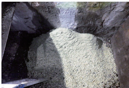
写真-3 FFU切削排土の様子
