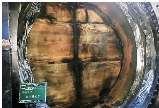
写真-2 発進坑口部のFFU
