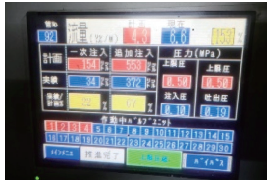
写真-9 ULISによる注入状況
