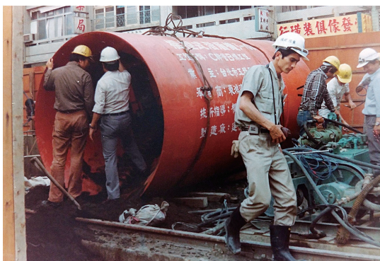
写真-3 約45年前の台湾（遠隔圧気式推進工事）
