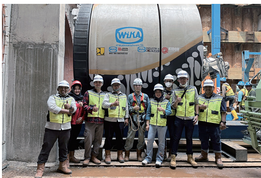
写真-8 インレット発進前（ジャカルタ、チリウン川放水路プロジェクト）
