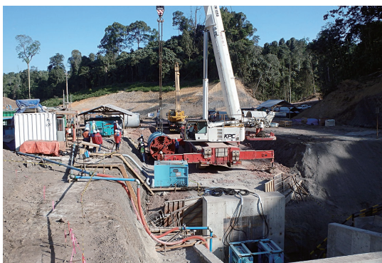
写真-7 カリマンタン（サンガタ鉱山人工池放水路工事）
