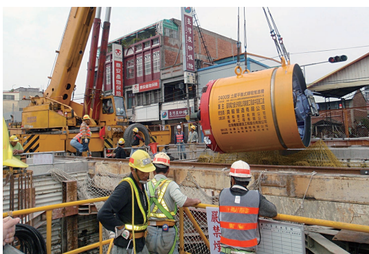
写真-4 現在の台湾の施工状況
