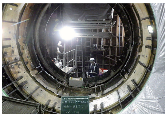
写真－10 掘進機解体完了
