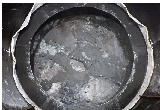
写真－7 到達坑口エアチューブ
