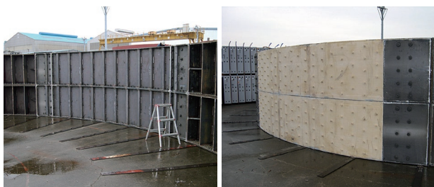
写真-2 発進坑口となるアーバンリングのFFUセグメント (左：内側、右：外側)
