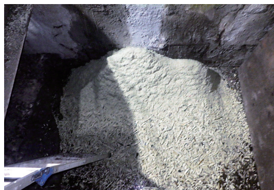
写真-4 FFU切削排土状況
