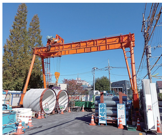
写真-1 発進ヤード
