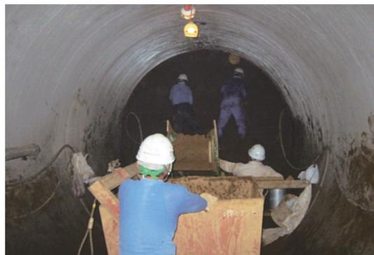
写真-2 刃口式推進切羽作業状況
