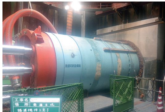
写真-4 初期掘進状況
