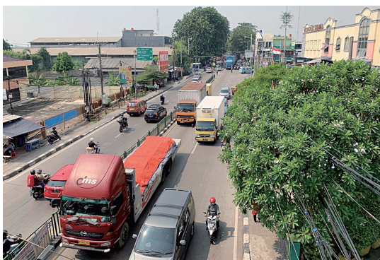
写真-6 推進現場状況
