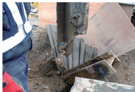
写真-1 掘進機で切削推進不能となったH鋼の引抜き状況
