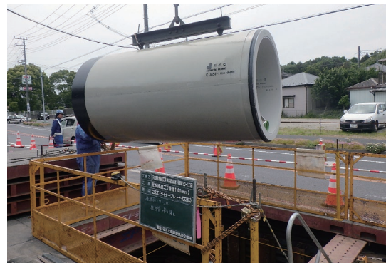
写真-4 コーティング剤を塗布した推進管
