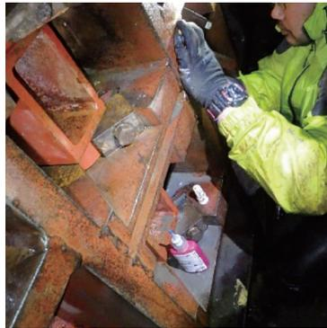
写真-9 ビット交換作業 (チャンバ内)
