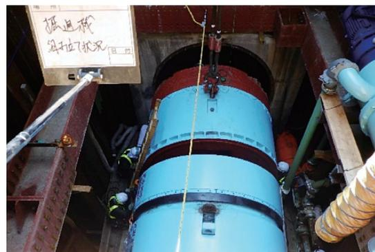
写真-7 立坑内での掘進機組み立て
