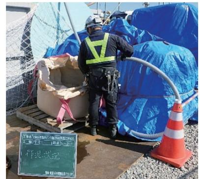
写真-13 作泥状況 (フレコンバッグから吸引)
