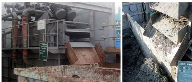
写真-1 一次処理機(機械式:坑外直接排土状況)
