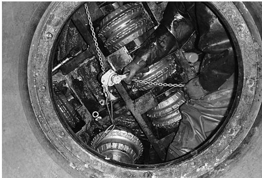
写真-7 2回目ビット交換（ローラビット再取付け）
