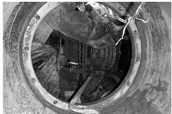
写真-5 1回目ビット交換（ローラビット取外し）
