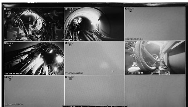
写真-4 推進管内監視出力の例
