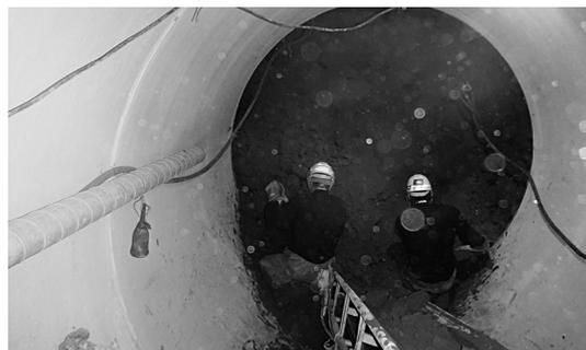
写真-1 刃口式推進（切羽掘削）
