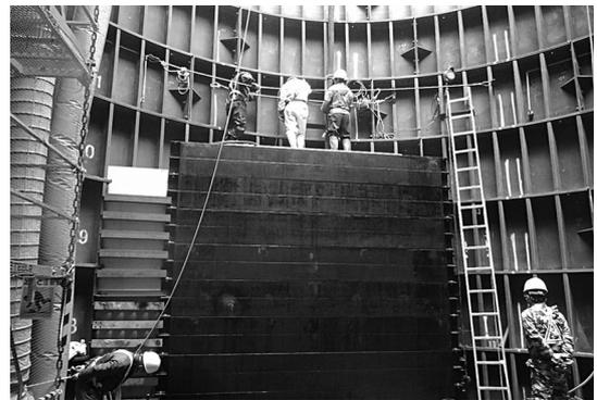
写真-15 プレキャスト支圧壁（バックロック）
