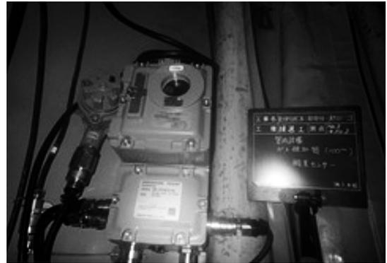
写真-3 定置式自動検知器（防爆構造）
