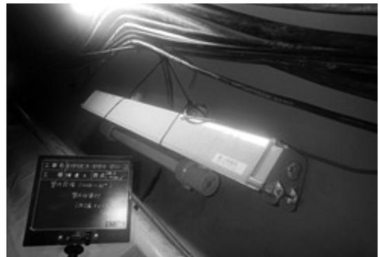
写真-4 非常用照明灯（防爆構造）
