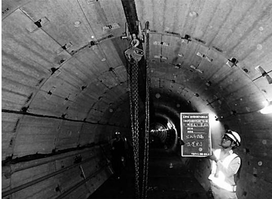
写真-2 シールド坑内吊設備
