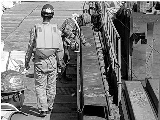
写真-6 栈橋上でパイルロック塗布
