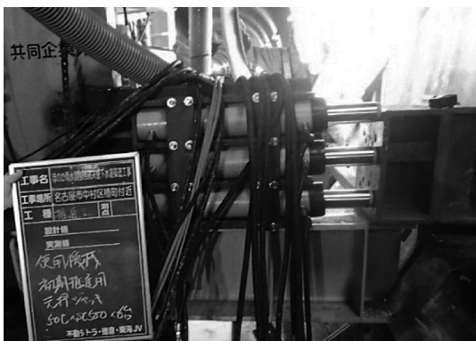
写真-16 初期掘進用元押ジャッキ
