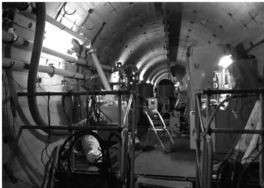
写真-4 推進用資機材設置状況
