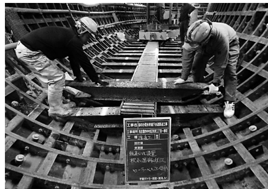
写真-2 運搬・設置状況
