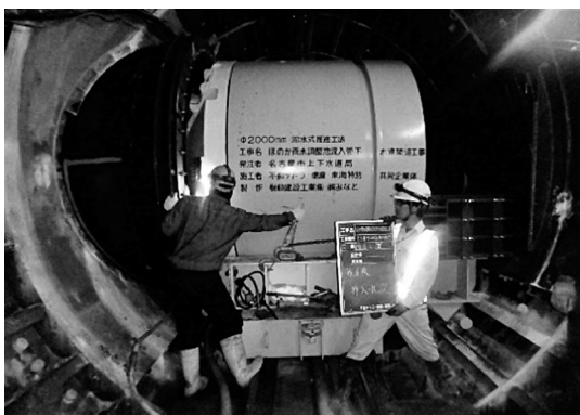
写真-8 掘進機坑口挿入状況
