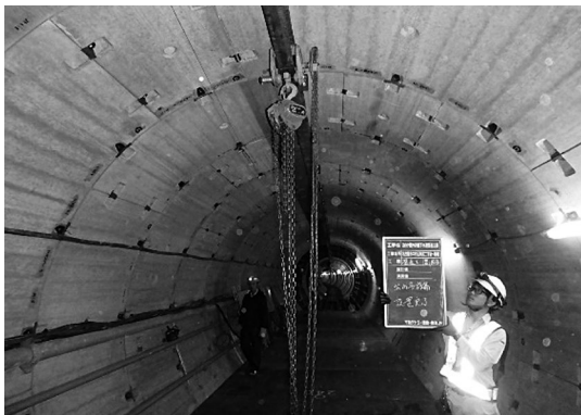
写真-3 シールド坑内吊設備
