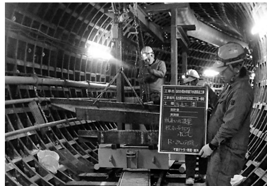
写真-1 枕木用鋼材吊下ろし状況
