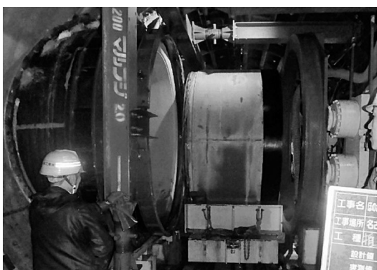
写真-18 推進管据付け状況
