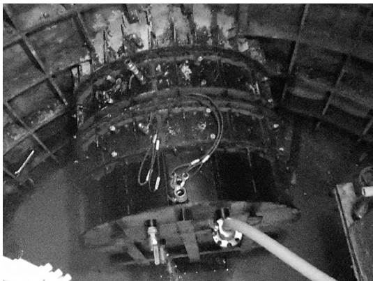
写真-6 到達坑口回収筒
