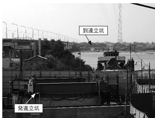
写真－7 管路上部
