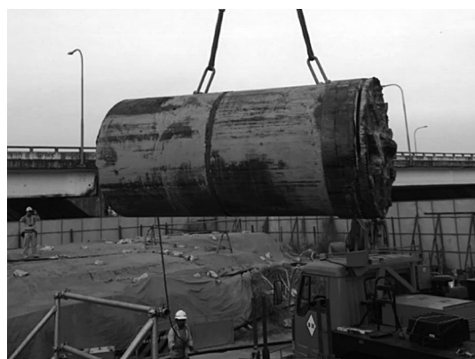
写真－12 掘進機吊上げ回収状況
