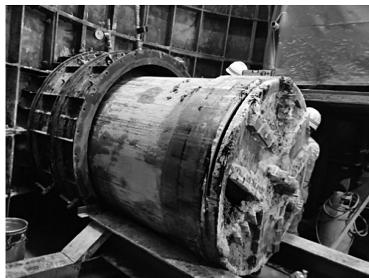
写真－11 掘進機押し出し状況
