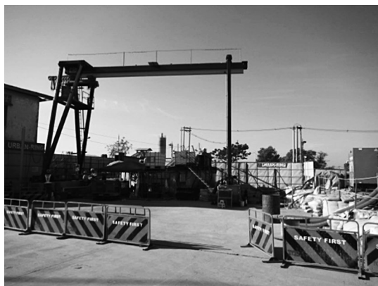
写真－9 発進基地全景（発進立坑）
