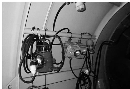
写真-9 ガス検知器 (切羽)
