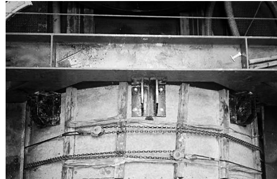
写真-2 バッキング防止インサートアンカ方式
