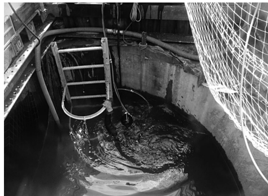
写真-5 潜水作業状況
