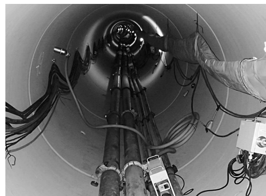
写真-11 ULIS管内バルブユニット
