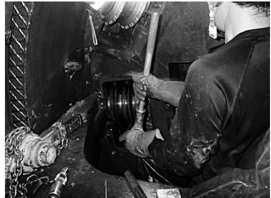
写真-6 機内ビット交換状況
