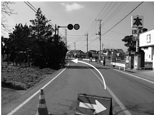
写真-4 推進管路上 (発進側～到達側)
