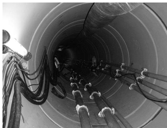
写真-11 管内状況 急曲線用特殊継手と推進管半管の区間
