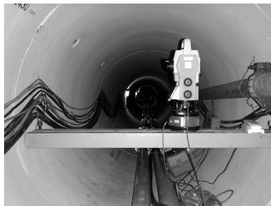
写真-3 管内自動測量機設置例
