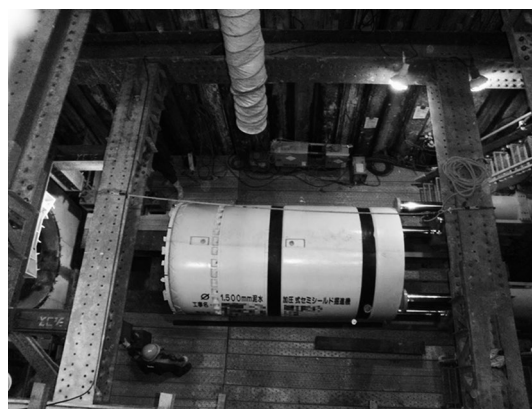
写真-5 発進立坑に掘進機を設置
