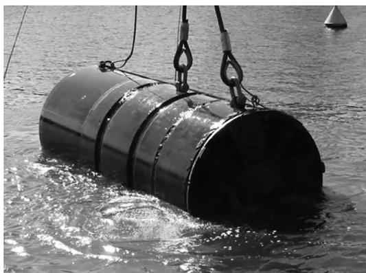
写真-12 掘進機+第1隔壁筒回収
