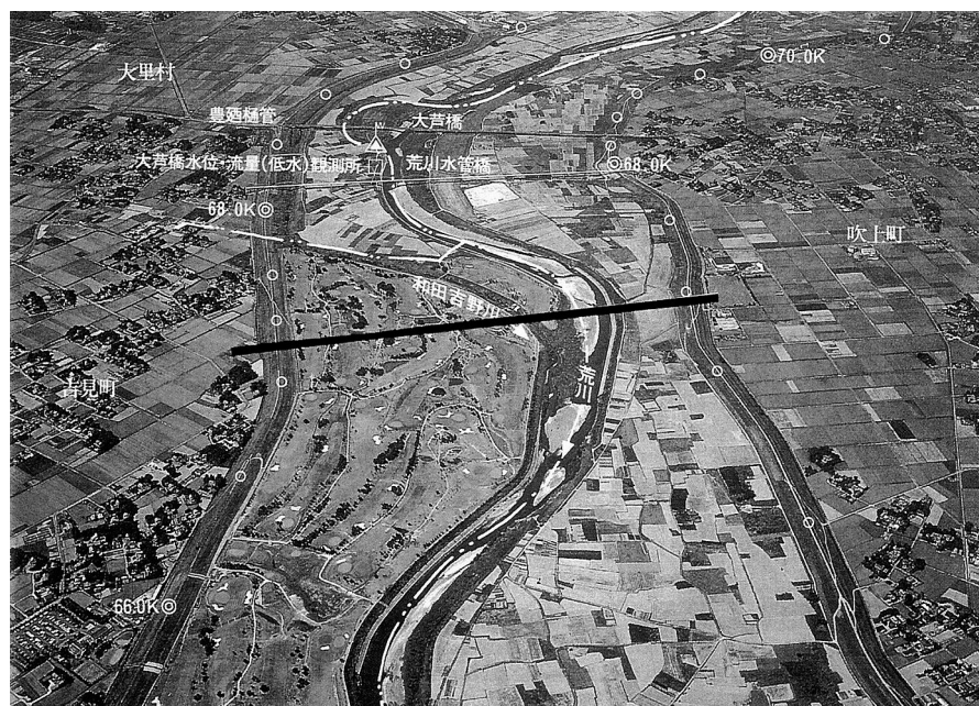
写真-6 施工位置 3)
