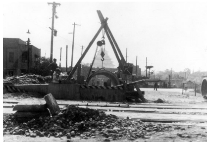
写真-1 昭和50年ごろの施工現場
