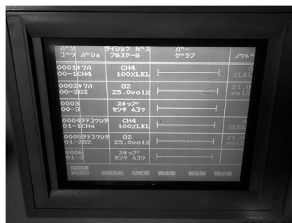
写真-7 自動ガス検知モニター
