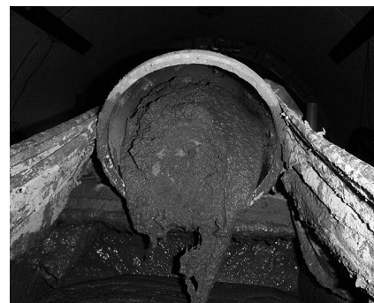
写真-2 排泥圧送状況
