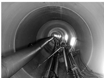
写真-6 管内換気(ターボファン使用)
