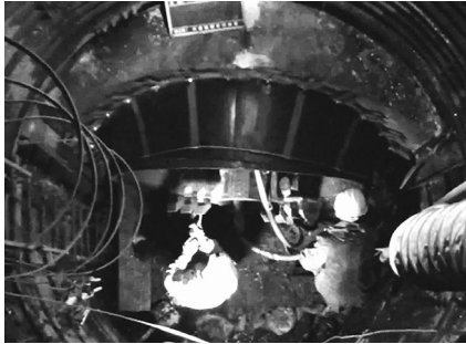
写真-1 円弧状の到達坑口工
