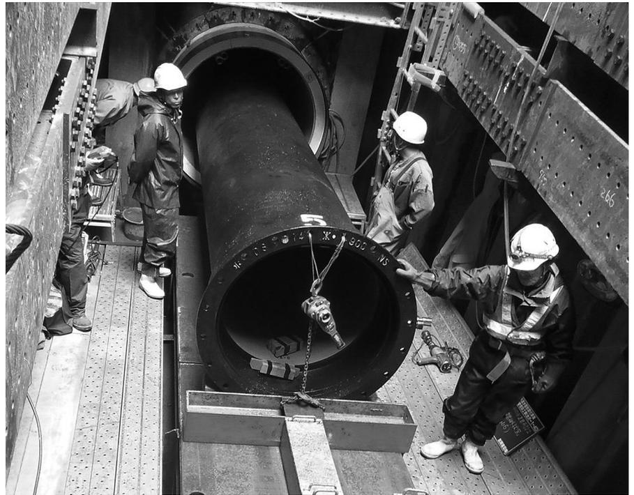
写真-9 本管（NS形ダクタイル鉄管）の挿入作業
