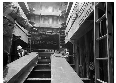
写真-4 推進架台の設置
