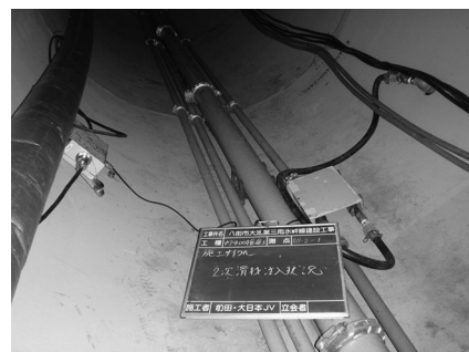
写真-9 自動滑材充填装置
