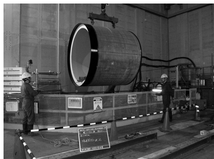
写真-15 推進管投入状況
