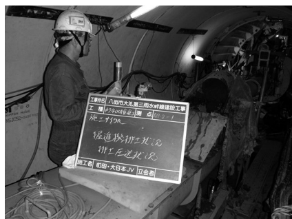
写真-13 排泥状況
