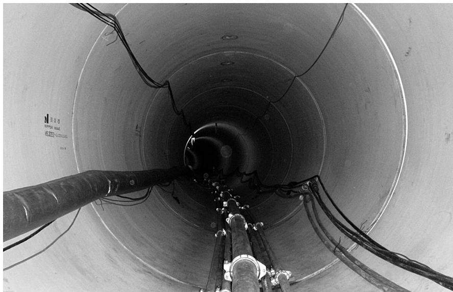
写真-19 左R=120m施工状況
