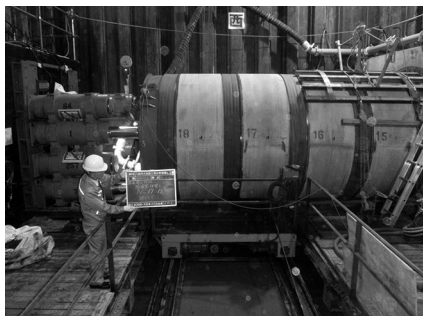
写真-18 本掘進状況
