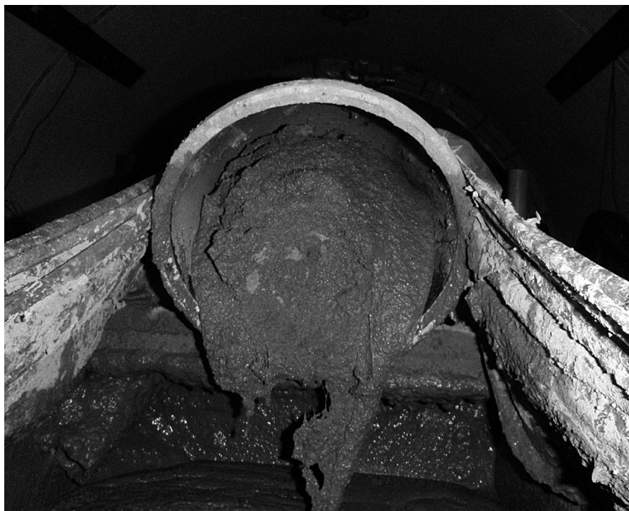
写真-14 排泥圧送状況
