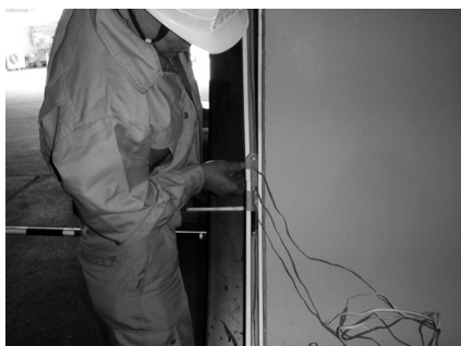
写真-7 応力計測取付け①
