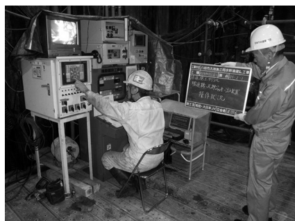
写真-16 掘進機操作状況
