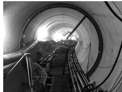
写真-4 内バンドの取付け状況
