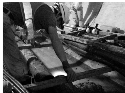
写真-6 管内閉塞の掃除
