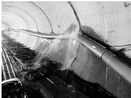
写真-2 滑材の流入状況
