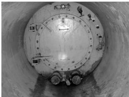
写真-11 第2隔壁 (水中回収システム) (このドアの向こう側は東シナ海)
