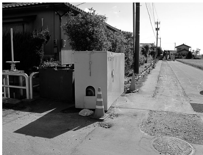
写真－12 ウェルポイント施工状況
