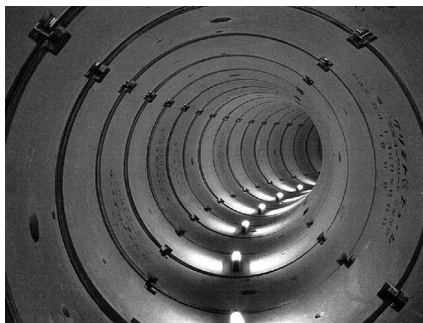
写真－8 開口制限装置
