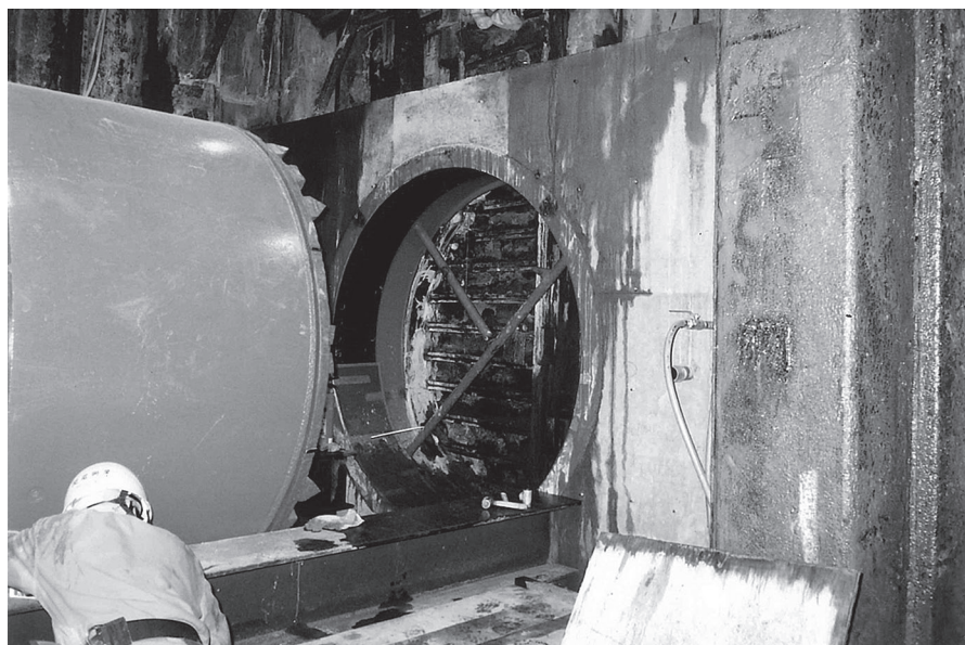
写真-6 エアチューブ発進坑口
