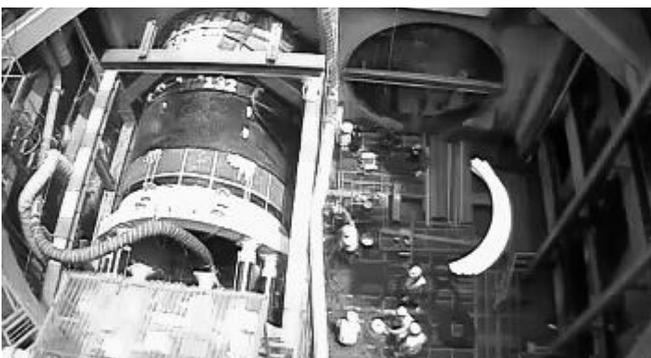
写真-10 第2中押管の設置
