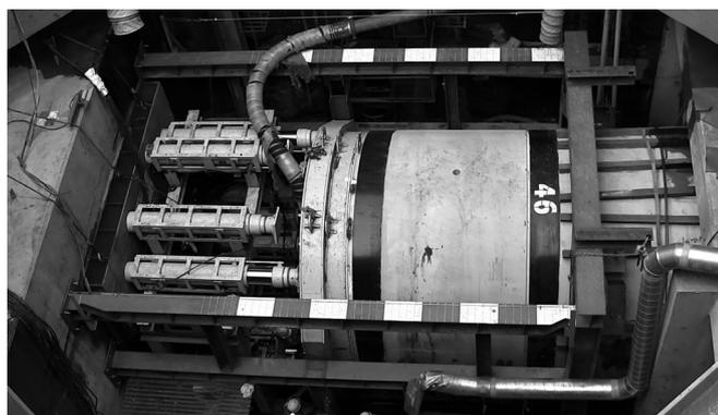
写真-3 バックキंग防止のH形鋼組鋼材
