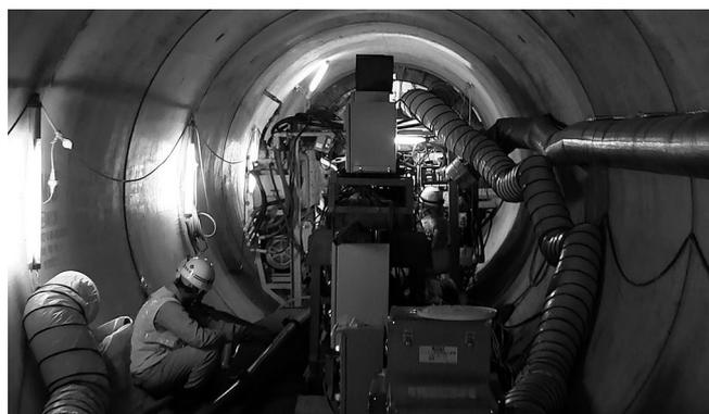
写真-4 掘進機後方設備
