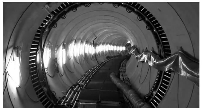
写真-11 中押管の管内設置状況
