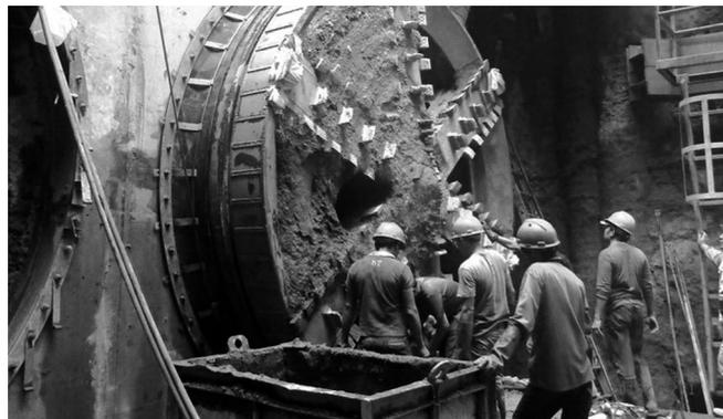
写真-13 掘進機押し出し
