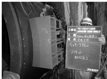
写真－11 バッキング防止ブラケット取付状況
