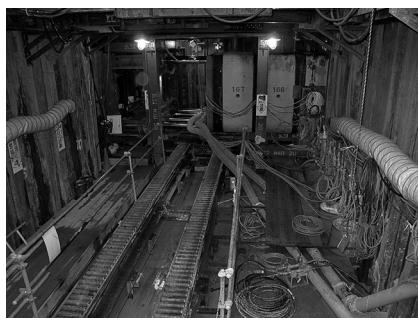
写真－2 トラバーサ（推進管横移動）
