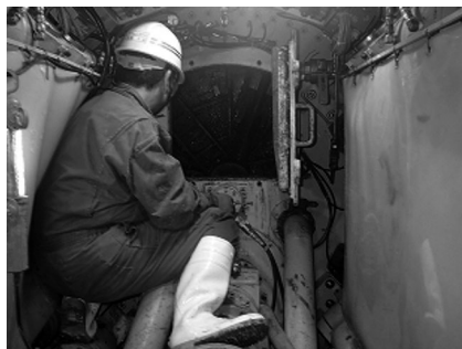
写真-15 不測障害物確認
