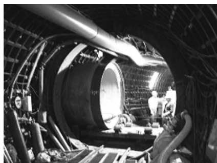
写真－1 推進管の横坑内への引き込み
