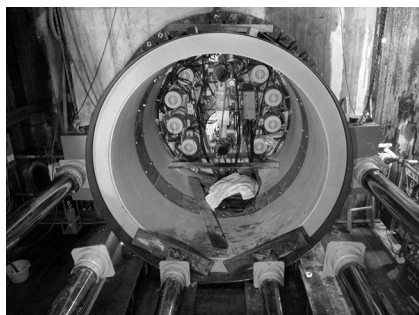
写真－12 バッキング対策
