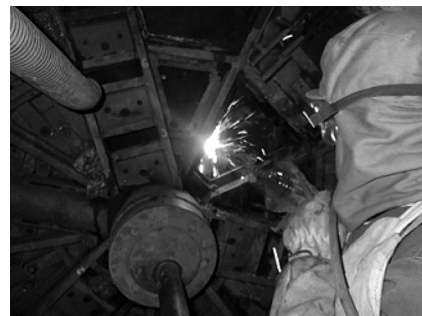
写真-16 不測障害物切断状況
