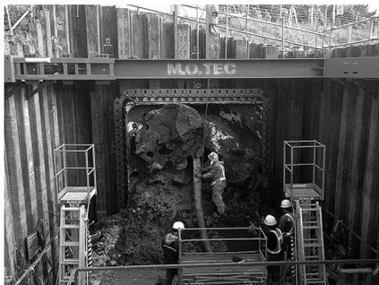
写真-4 ボックス推進施工状況
