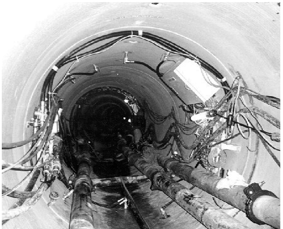
写真-9 中間摩擦低減装置
