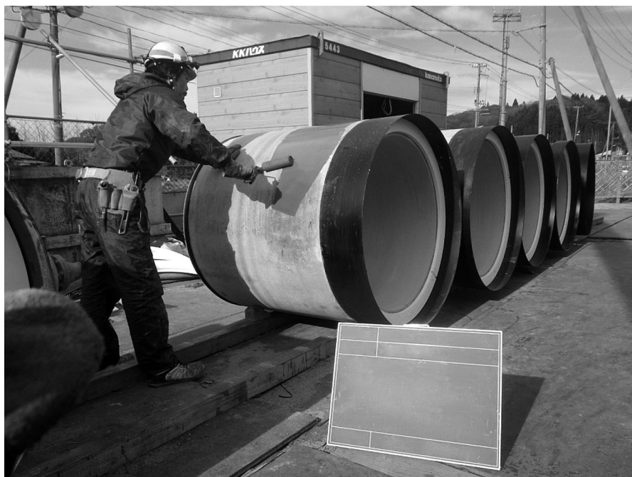
写真-11 コーティング材の塗布作業状況
