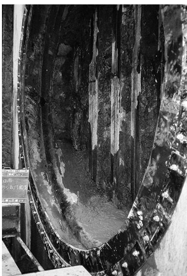
写真-7 ゴムパッキン+ワイヤブラシ形式の坑口
