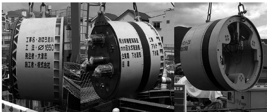
写真-4 掘進機の三分割搬入
