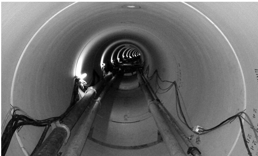
写真-2 曲線推進施工例
