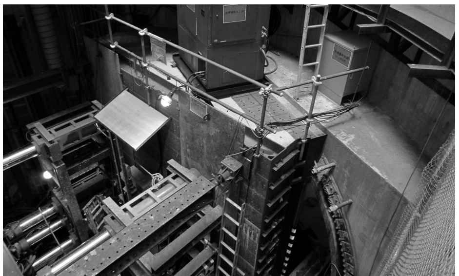
写真-8 プレキャスト支圧壁
