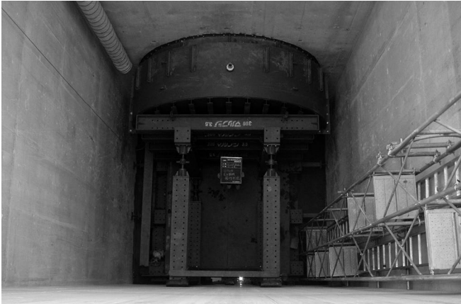
写真-13 掘進機回収筒全景
