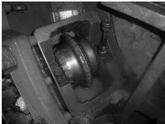
写真-22 ビット交換 (チャンバ内)
