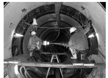
写真-4 曲線内での中押稼働状況
