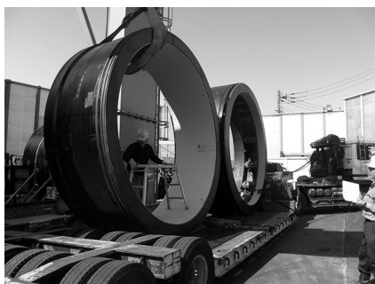
写真-1 特殊中押管 S型、T型
