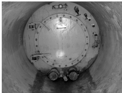
写真-19 第2隔壁 (水中回収システム)
