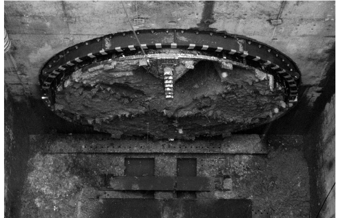
写真-14 回収筒撤去
