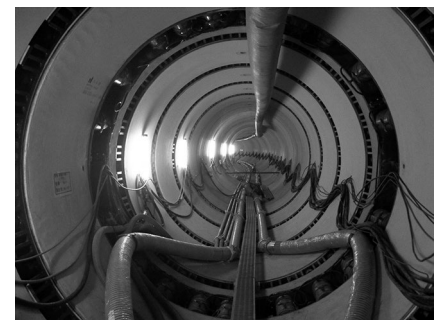
写真-3 管内状況（曲線部）
