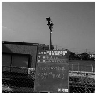
写真-8 立坑上のWEBカメラ
