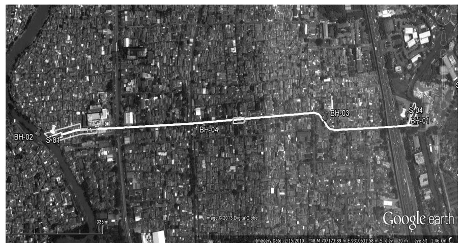
写真-3 施工場所(航空写真)
